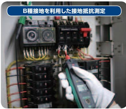
B種接地を利用した接地抵抗測定
