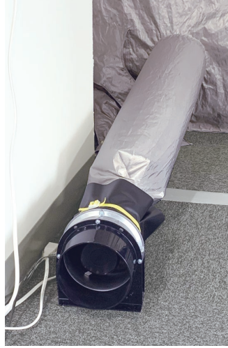
吸気口(送風機取付時)
